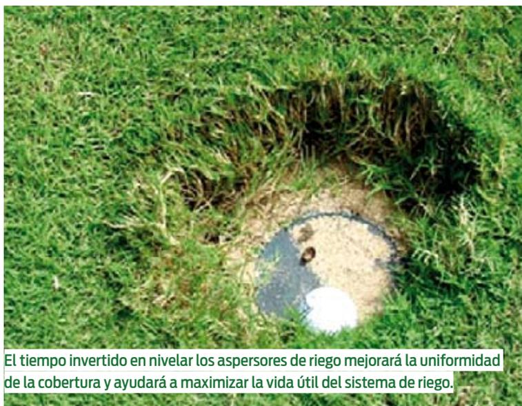
El tiempo invertido en nivelar los aspersores de riego mejorará la uniformidad de la cobertura y ayudará a maximizar la vida útil del sistema de riego.
