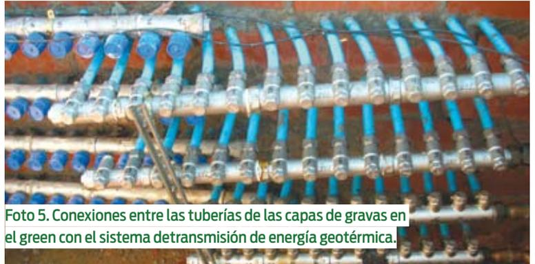
**Foto 5.** Conexiones entre las tuberías de las capas de gravas en el green con el sistema de transmisión de energía geotérmica.
