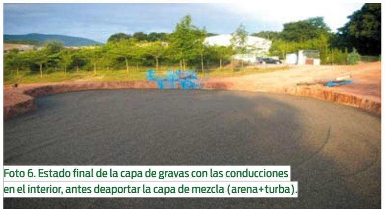
**Foto 6.** Estado final de la capa de gravas con las conducciones en el interior, antes de depositar la capa de mezcla (arena+turba).
