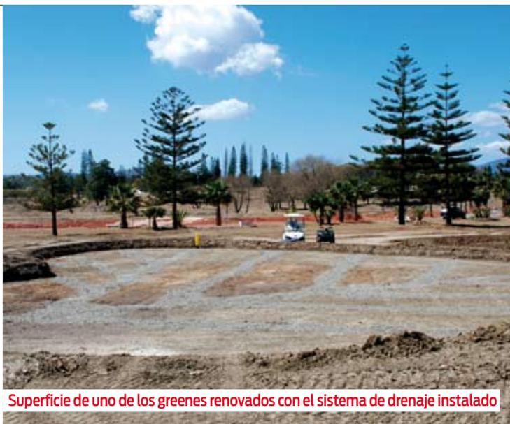
Superficie de uno de los greens renovados con el sistema de drenaje instalado
