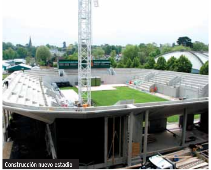
Construcción nuevo estadio
