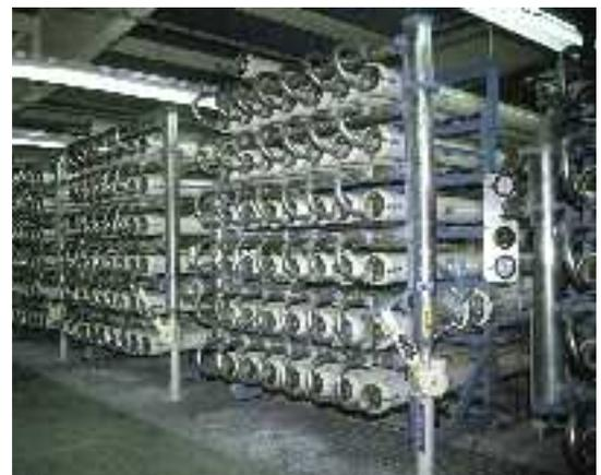
Izquierda: planta piloto de microfiltración previa a la ósmosis inversa, como pretratamiento de ésta. Centro: cartel indicador de uso de agua regenerada. Derecha: bastidores OI de una unidad de tratamientos terciarios para ósmosis inversa que regenera agua para darle calidad de agua potable e inyectarla en el acuífero. Así se protege a éste de intrusiones marinas y se recarga el acuífero para usos potables. California, EEUU.
