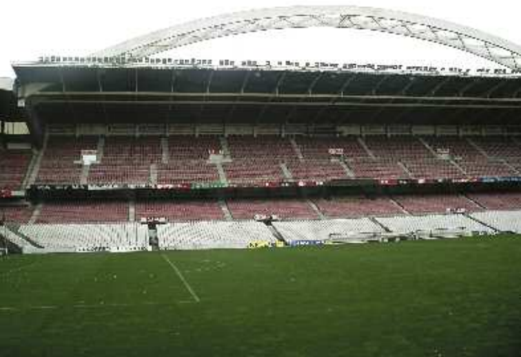
Estado actual del campo del estadio de San Mamés.
