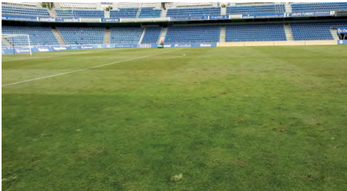
Estado del estadio antes de la remodelación
