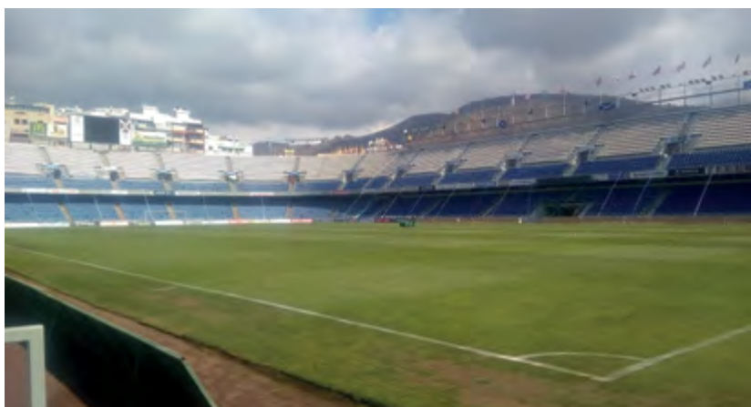
Estado del estadio antes de la remodelación
