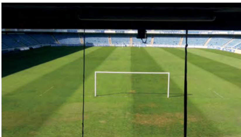
Estado del estadio antes de la remodelación
