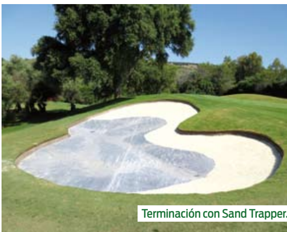
Instalación lámina protectora.
