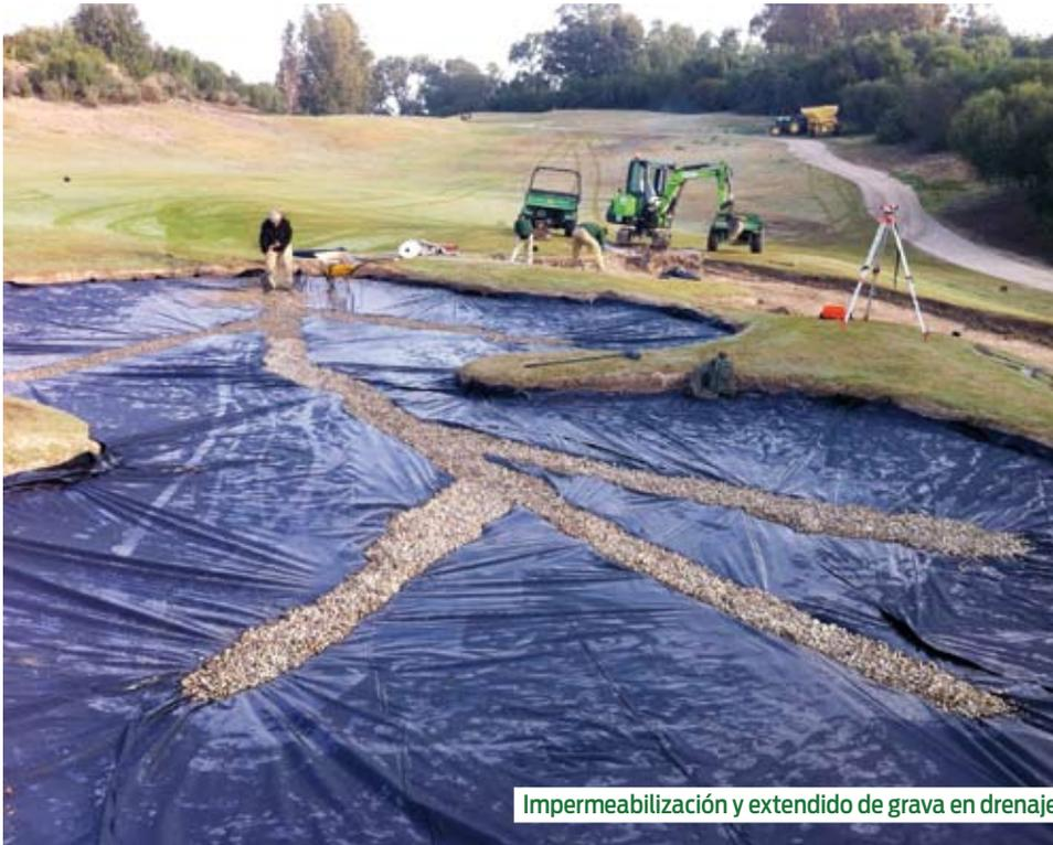
Impermeabilización y extendido de grava en drenaje.
