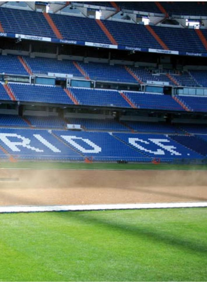
El cajado se realiza a una profundidad de 80 mm, sobre la que se coloca un geotextil anti-malas hierbas que sirve de elemento separador
