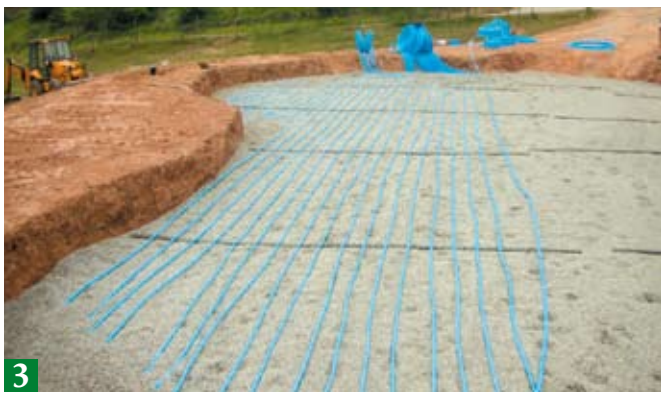
Fotos 1 y 2. Instalación de la capa de tuberías para el recorrido del agua procedente de los pozos, en contacto con la base del green.
