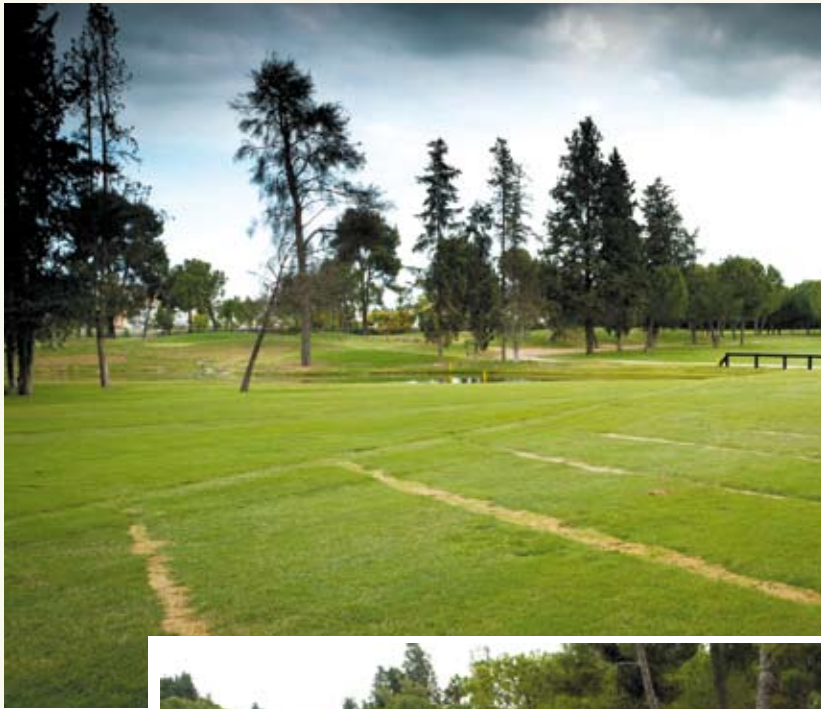
Arriba y a la derecha: ejecución drenaje francés en calle
