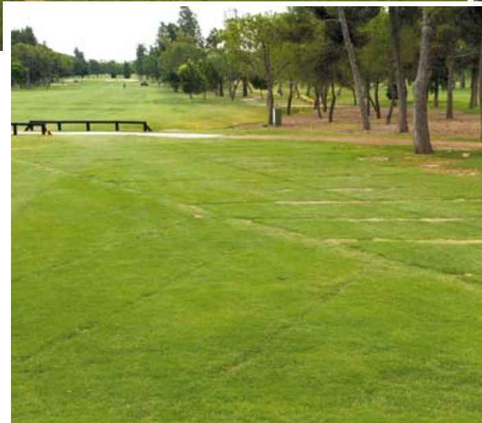
Arriba y a la derecha: ejecución drenaje francés en calle
