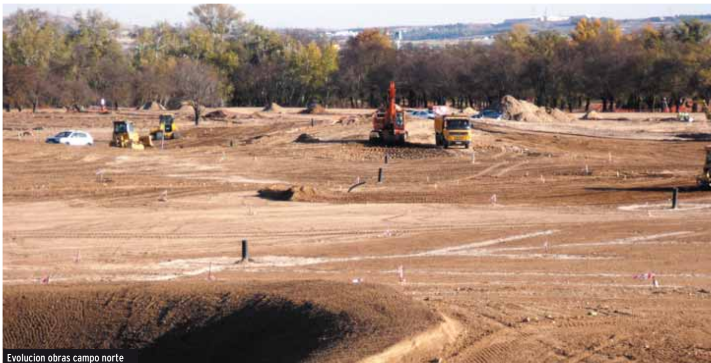
Evolucion obras campo norte
