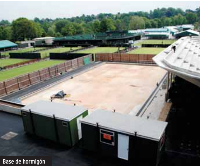
Base de hormigón
