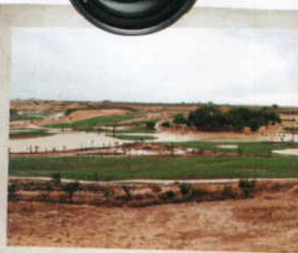
Inundaciones afectando a Ochando Golf (Murcia)
