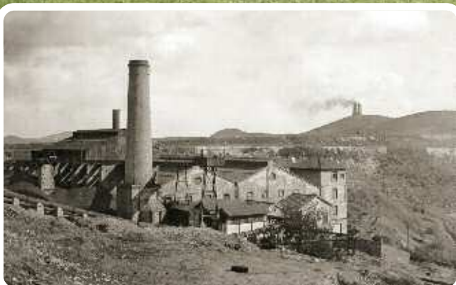
Central eléctrica Riotinto.
