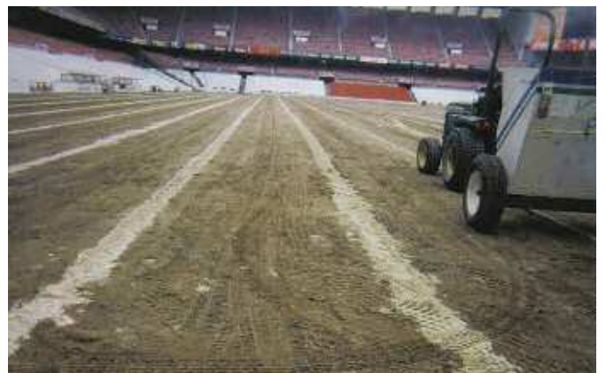
Drenaje superficial reforzado.
