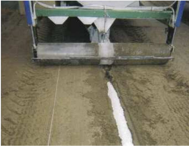
Realización de drenaje.
