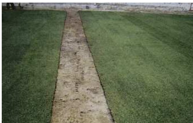
Colocación de tepes.
