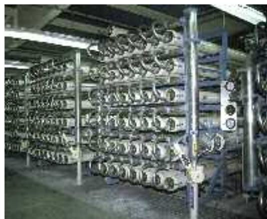
Izquierda: planta piloto de microfiltración previa a la ósmosis inversa, como pretratamiento de ésta. Centro: cartel indicador de uso de agua regenerada. Derecha: bastidores OI de una unidad de tratamientos terciarios para ósmosis inversa que regenera agua para darle calidad de agua potable e inyectarla en el acuífero. Así se protege a éste de intrusiones marinas y se recarga el acuífero para usos potables. California, EEUU.
