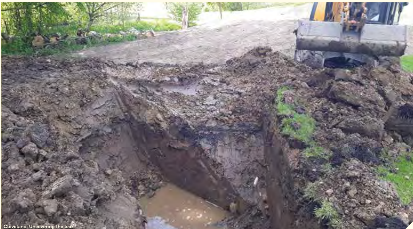
Cleveland: Uncovering the leak
