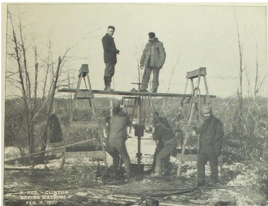
.I. CLINTON BORING APPARATUS.
